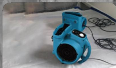
水損修復作業
